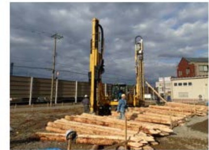
丸太杭の搬入状況
