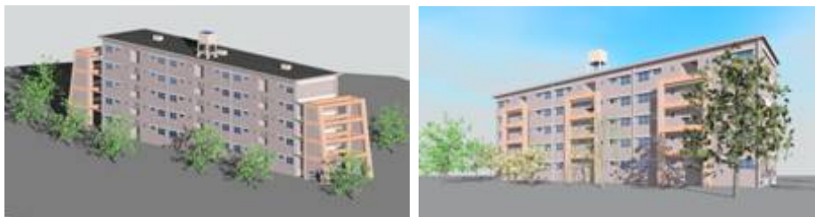
アウトフレーム外観のパス
