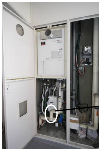
給湯24号、潜熱回収高効率給湯暖房機へ
