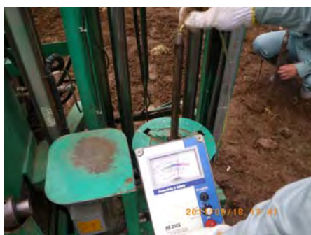
SWS試験孔を利用した地下水位測定状況
