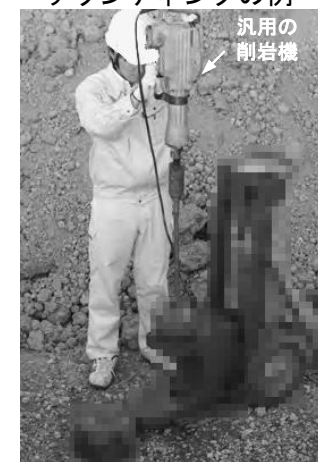
図 5 硬質層を貫通させるための打撃例
