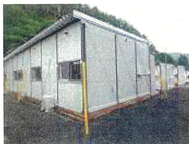
写真: 応急仮設住宅(岩手県)
