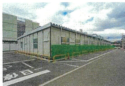
写真: コロナ対応のための応急仮設建築物(大阪府)
