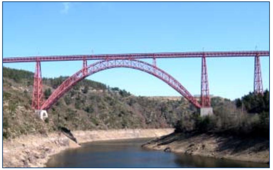
エッフェル塔の試金石となった全長564m、スパン165.2mのガラビ橋-1884年-(エッフェルが錬鉄で設計)
