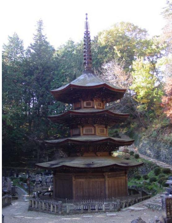
木々の間に、八角三重塔が端然と建っています。建立時期は、鎌倉北条氏の外護によって栄えた寺で、北条氏の滅亡後このように立派な塔婆の建立は考えにくいので、鎌倉時代末期に建てられたと推察されます。平成十六年の調査結果によると、三重塔用材の伐採年代は正応二年（1289）ということが判明した。これにより少なくとも 1290 年代（鎌倉時代末期）には建立されたことが明らかになった。塔は、礎石上に直接建ち、縁もつけていない禅宗様八角三重塔で、高さは 18.8m です。初重に裳階を付けた珍しい形式である上に、細部もまた禅宗様からなった類例が少ないものです。軒は裳階を含めて全層とも二軒の扇垂木とし、詰組、波型連子、木鼻等が用いられています。内外とも巧みな意匠と、珍しい形式よりできているこの塔は、奈良の西大寺、京都の法勝寺などの八角塔婆が失われた今日、我国に残された唯一の八角塔婆であり、禅宗寺院に残る塔婆としても極めて重要な遺構であります。
