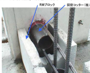
RMブロック及び鋼管コッター（柱）
