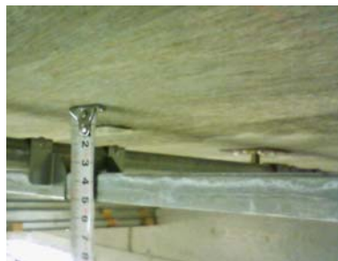
写真2 天井懐空気層 (50 mm)
