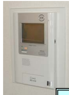
新設モニター付インターホン親機
