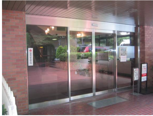
エントランス全景
