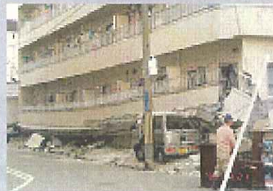
阪神大震災における被害
