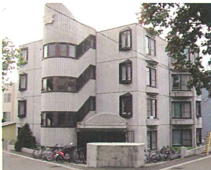
札幌市内のSBR混入RCマンション2004年撮影
