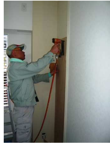
③制振パネルをタッカー止め
