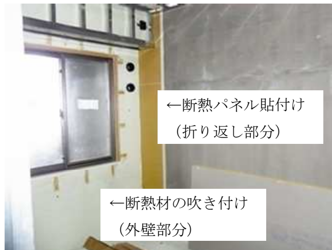
図-4 現場での施工状況
