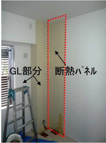
①断熱パネルのクロス剥がし
