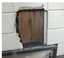
サイディングの一部を撤去
