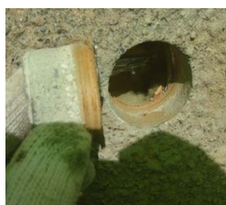
コアドリルで撤去
