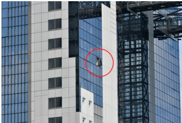
割れたガラスの隙間から構造部材と思われる部材が見え、ガラス破片は周囲に飛散
