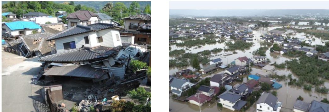
図1. 2016年熊本地震、2019年台風19号の被災状況(国土地理院 UAV 画像より)
