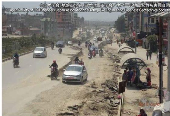
図6: 図1において局所的な変動が見られた場所の現地写真 撮影場所は、図5の枠(2)内の丸印の位置。 道路の片側が沈下している。
