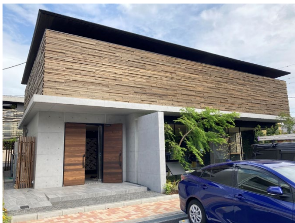
木質建材を外部仕上に使用した住宅例(当社木造住宅展示場)
