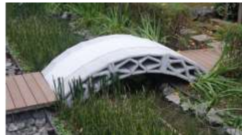
写真 4 小規模構造物の例
